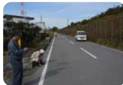
きれいになった道路
